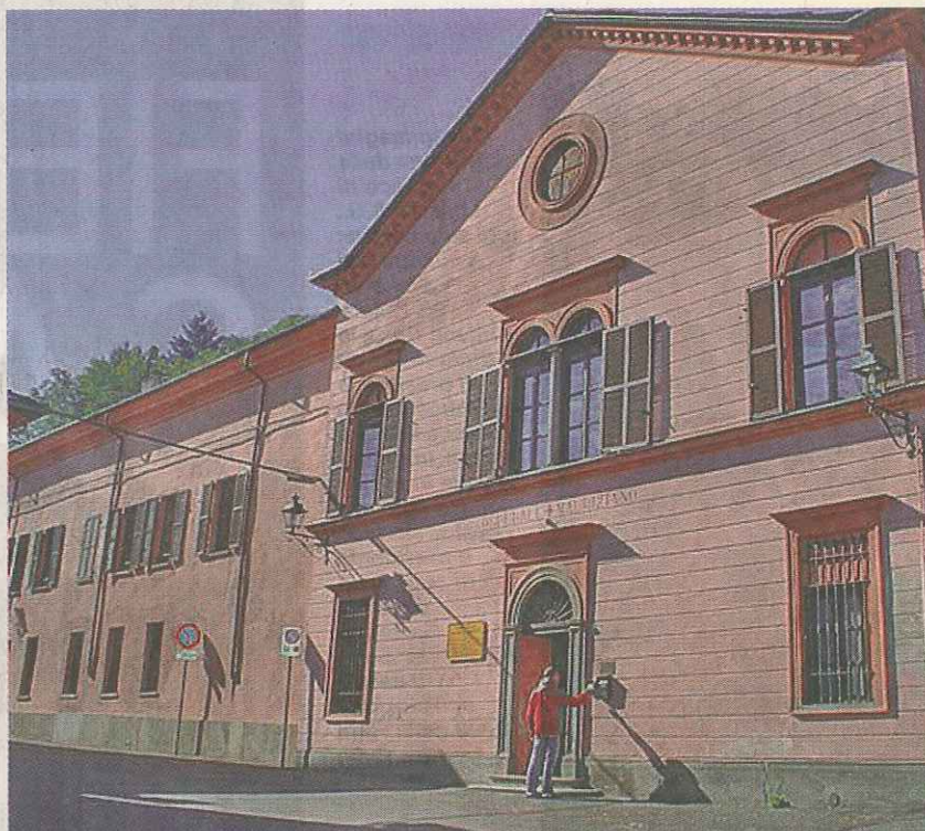
L'ingresso dell'ex-ospedale Mauriziano, storico edificio di Luserna Alta, che oggi accoglie disabili psichici con disturbi del comportamento.
